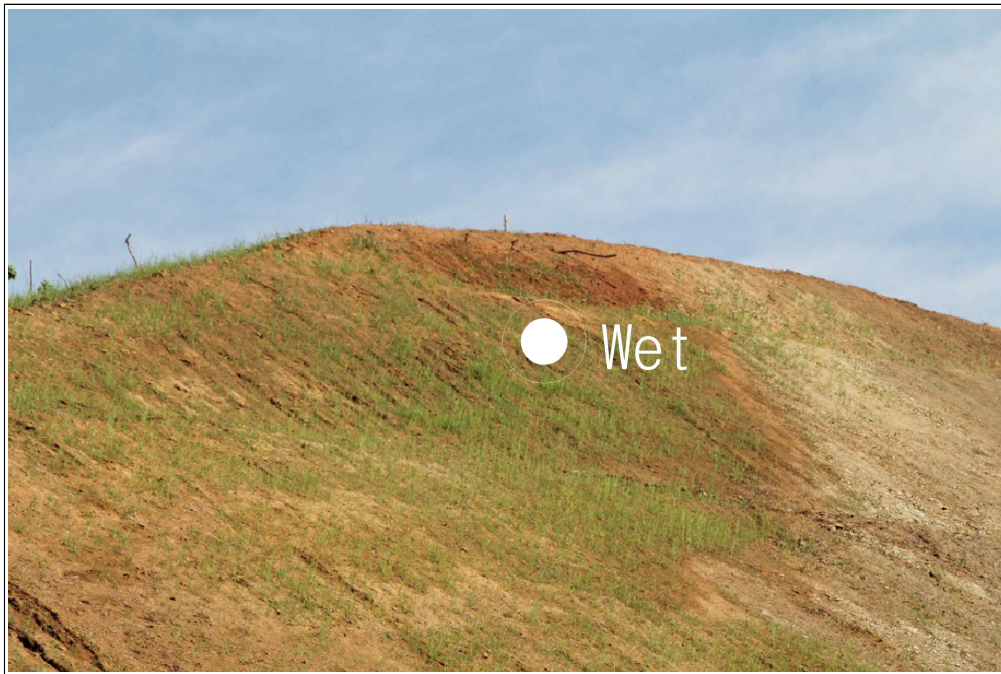
【그림 18】 A 영역 상세사진 (지하수 유출)
