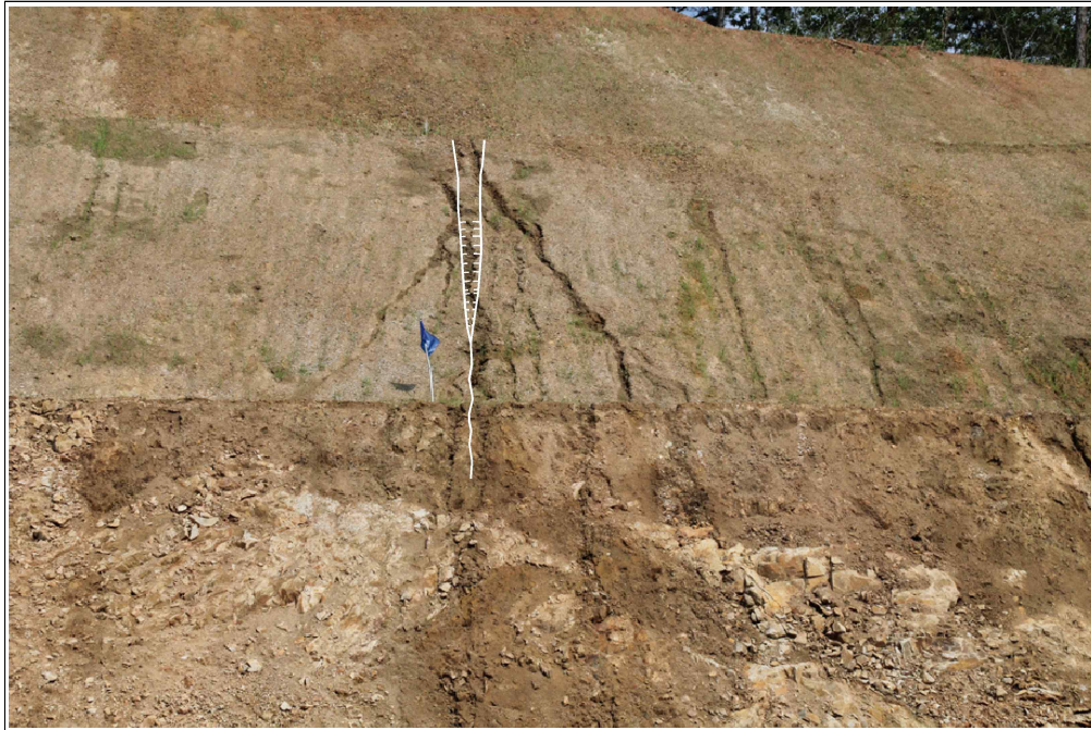
【그림 21】 B 영역 상세사진 (세굴 발생)
