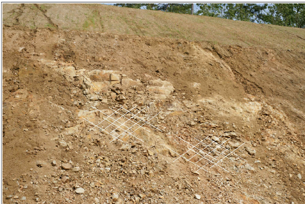
【그림 22】 B 영역 상세사진 (세편화된 암석)
