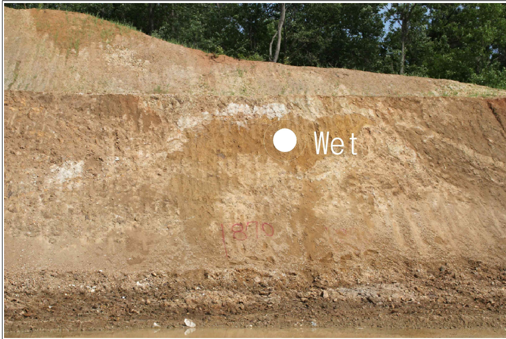
【그림 25】 B 영역 상세사진 (지하수 유출)
