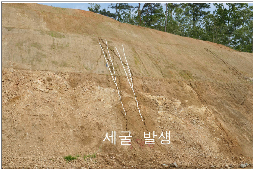
【그림 20】 B 영역 상세사진 (세굴 발생)
