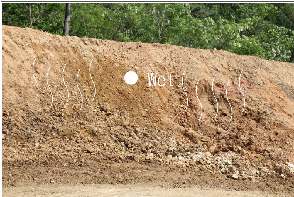
【그림 24】 B 영역 상세사진 (지하수 유출 및 토사유실)
