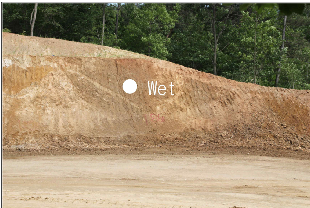
【그림 26】 B 영역 상세사진 (지하수 유출)
