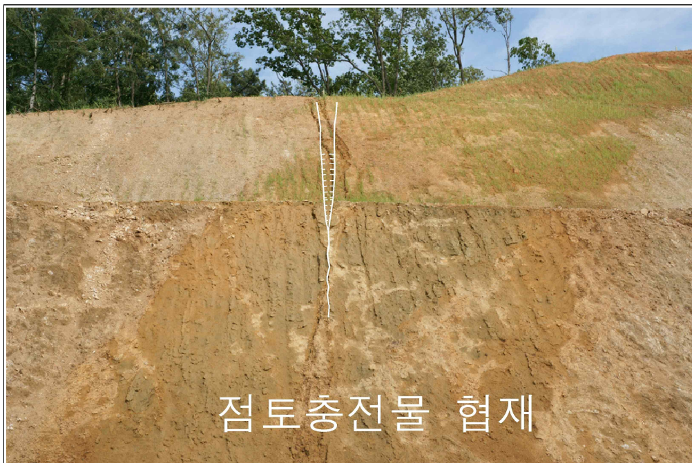
【그림 17】 A 영역 상세사진 (점토충전물 협재 및 세굴)
