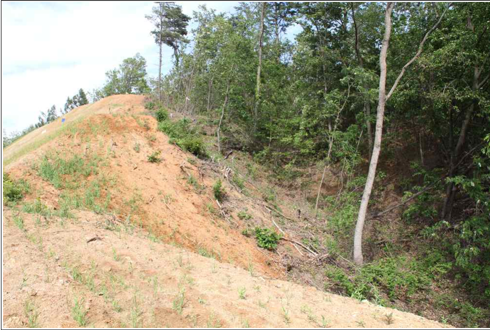
【그림 5】 상부 자연비탈면 (수목의 기울어짐 및 포행)
