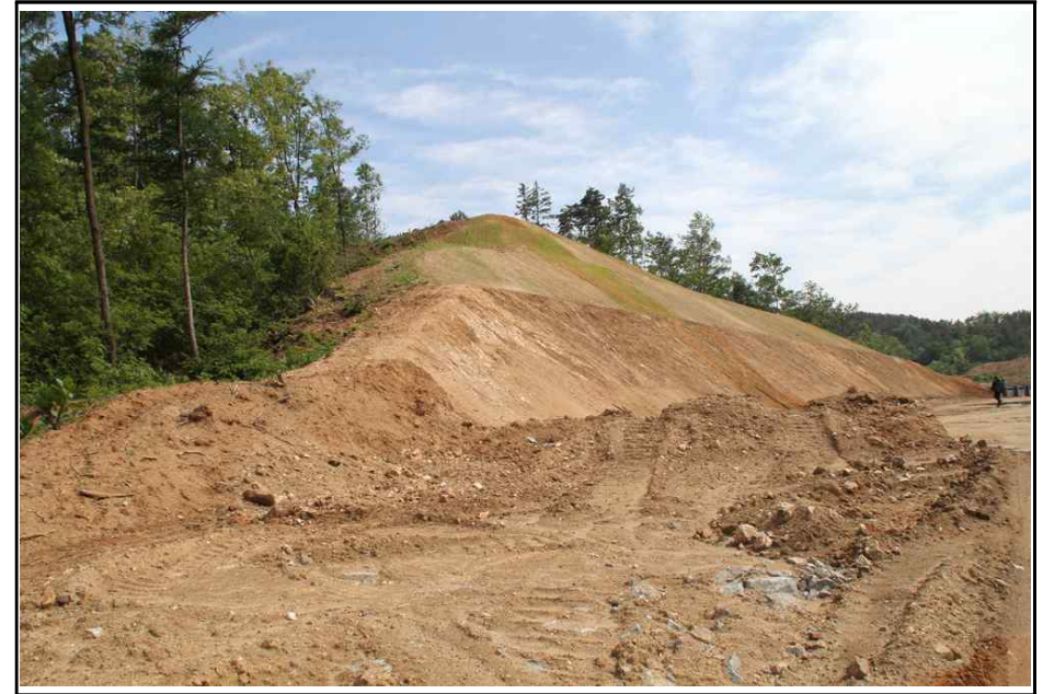
【그림 4】 깎기비탈면 종점부 측면 사진
